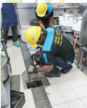
ทำความสะอาดท่อของแต่ละร้านค้าในโรงอาหาร Clean the sewer of in the canteen
